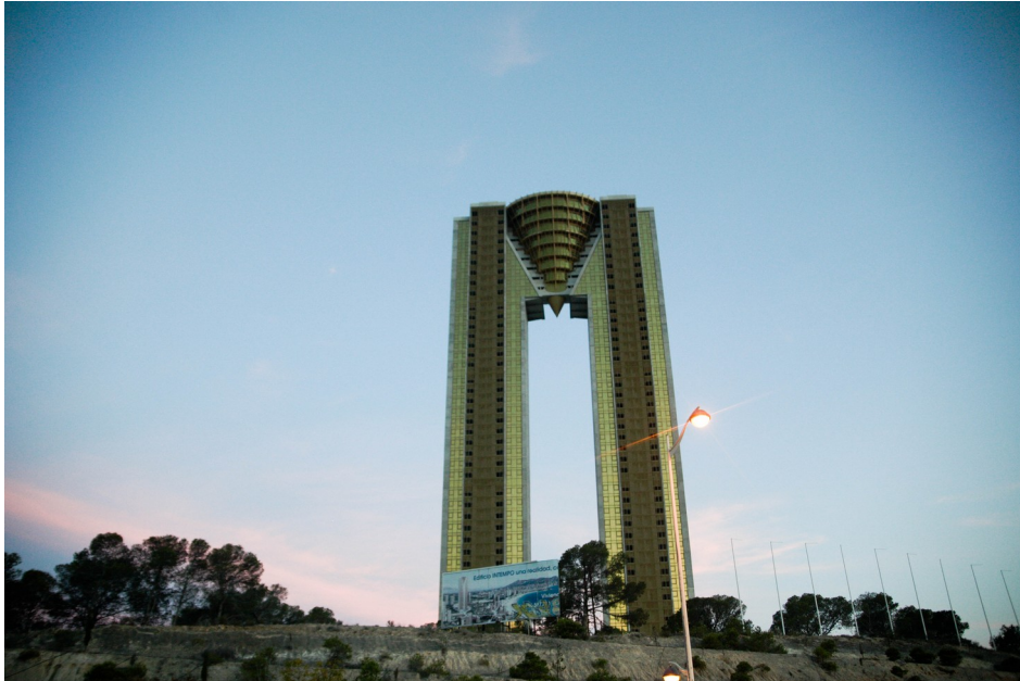
Figura 3: Construção de prédio abandonado no município de Benidorm, Valencia
