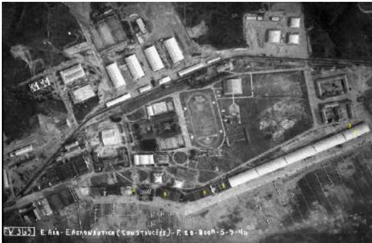
Figura 67: Localização dos principais departamentos visitados para a pesquisa: (1) Edifício principal entrada para a exposição permanente do Musal (2) Hangar cinco (3) Guarda do AH (4) Processamento técnico do AH (5) Biblioteca (hangar de restauração) (6) Antigo AH (hangar de restauração). (Arquivo Histórico do Musal)
