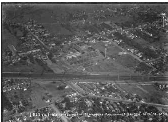
Figura 103: Subestação elétrica em Cascadura, 1938 (Arquivo Histórico do Musal)
