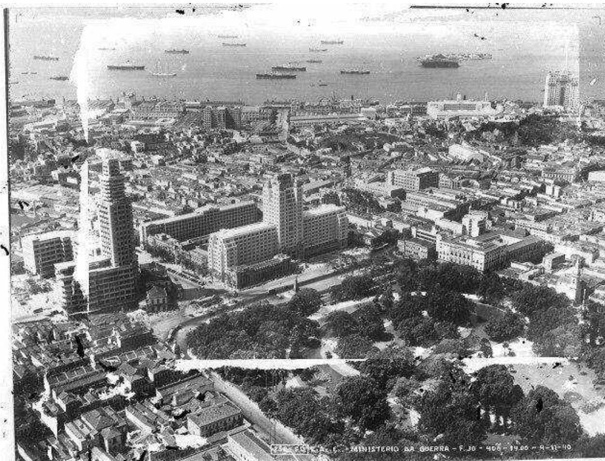
Figura 136: Os novos edifícios da Central do Brasil e do Ministério da Guerra em construção por trás dos antigos, Centro, 1940. (Arquivo Histórico do Musal)
