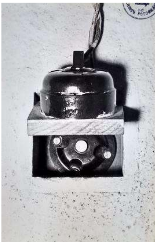
Figura 45 – Alarme sonoro camuflado sob o interruptor de energia. Fonte: Arquivo Público do Estado do Rio de Janeiro (APERJ)
