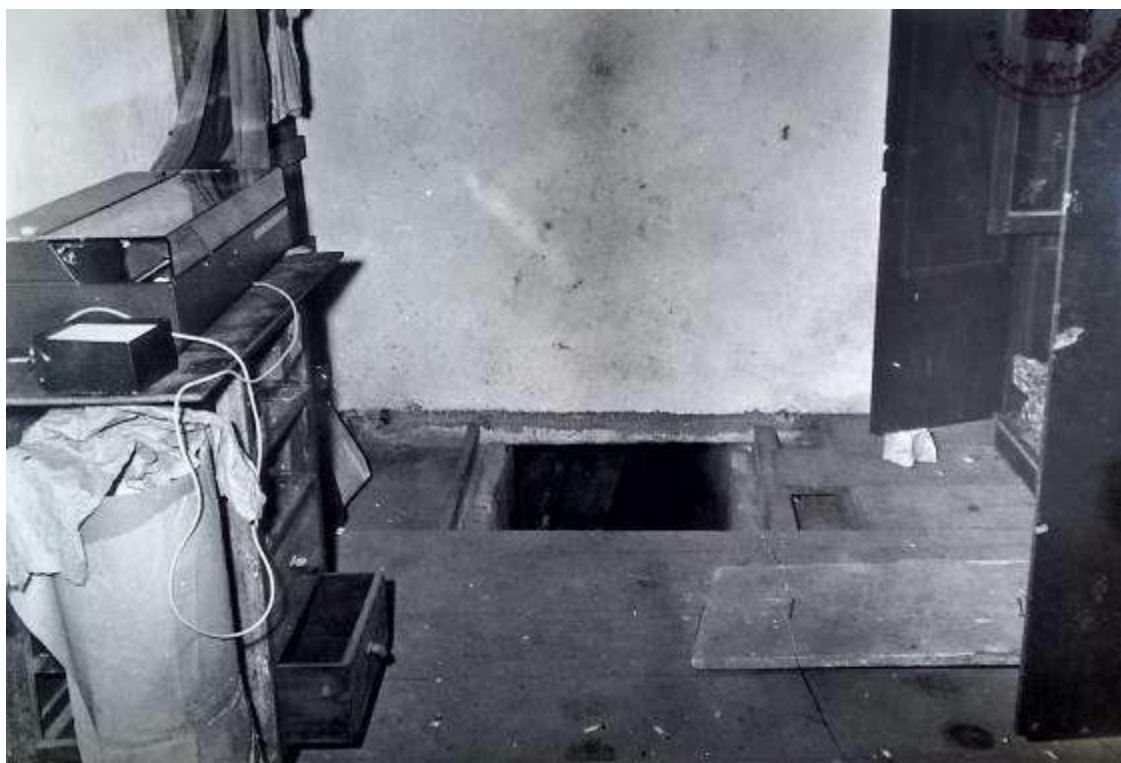
Figura 44 – Abertura sob o piso em formato de “tampa de cisterna”. Fonte: Arquivo Público do Estado do Rio de Janeiro (APERJ)
