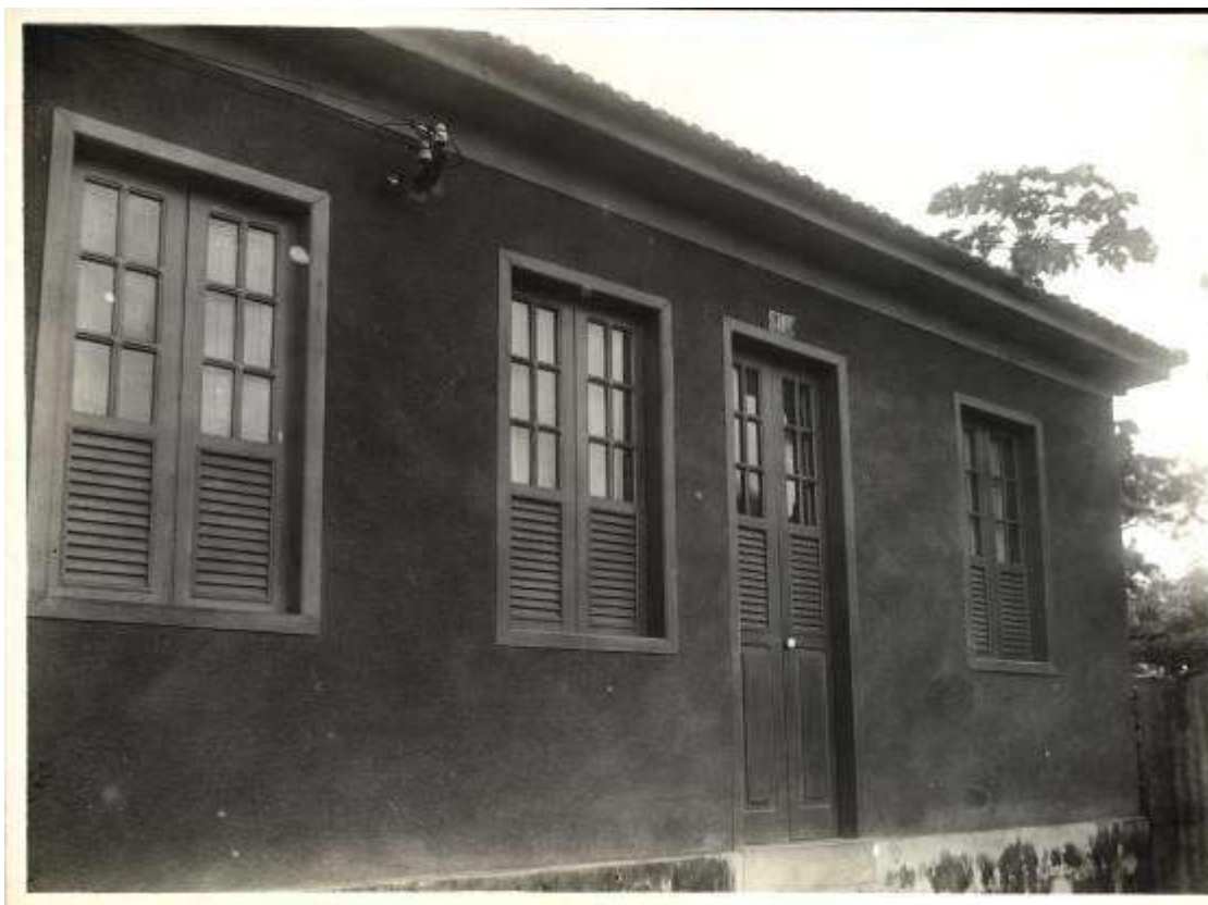
Figura 24 – Casa em Irajá onde Adalcinda, companheira de Elias, foi presa. Fonte: Arquivo Público do Estado do Rio de Janeiro (APERJ)
