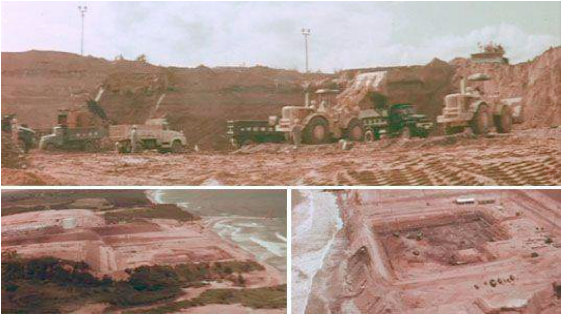
Figura 24 - Sitio de construcción de Fukushima Aichi a finales de los años 60. Fuente: Remei.
