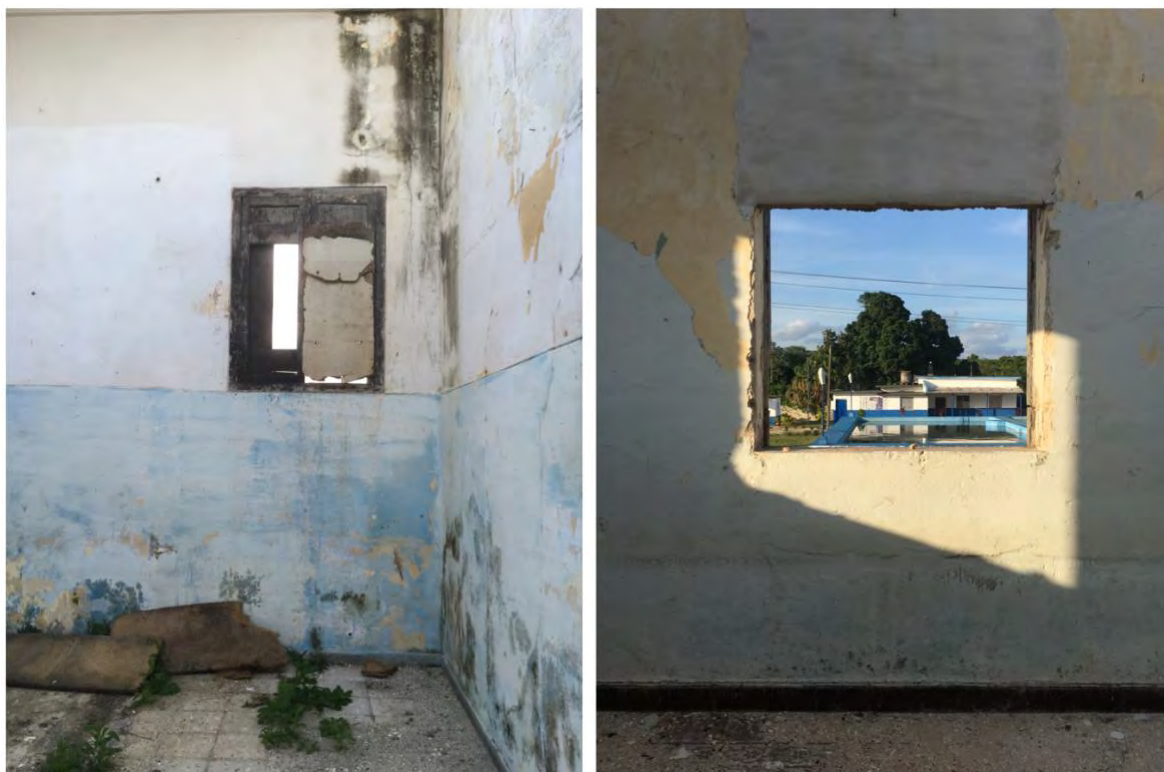
Figura 60 – Estudo de locação para filmagem em uma escola abandonada no centro de San Antonio de los Baños, novembro de 2019
