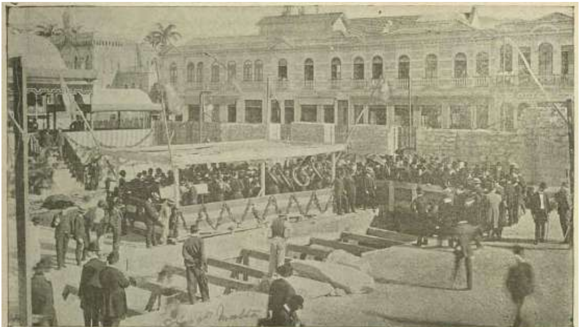
FIGURA 61: OBRAS DO THEATRO MUNICIPAL, POR AUGUSTO MALTA
