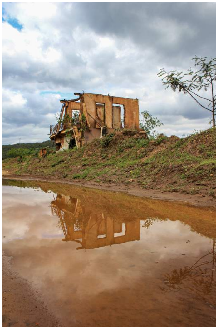
Figura 4 – Casa do seu Filomeno, em Bento Rodrigues (MG), em 20 de outubro de 2019 Fonte: primária
