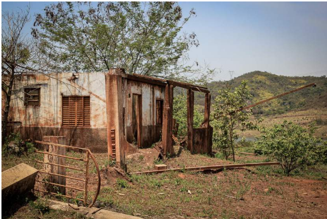
Figura 24 – Casa grande e direita, de telha colonial Fonte: primária
